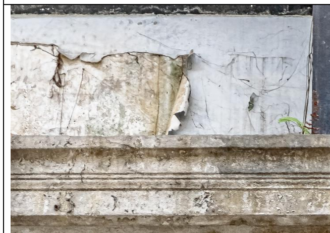
Fig.09 – Nota-se deslocamento da pintura e vegetação invasora.
