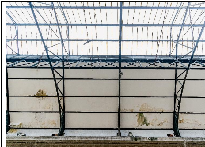
Fig.03 – Vista geral de trecho do forro. Pontos de infiltração, mofo e bolor e deslocamento da pintura.
