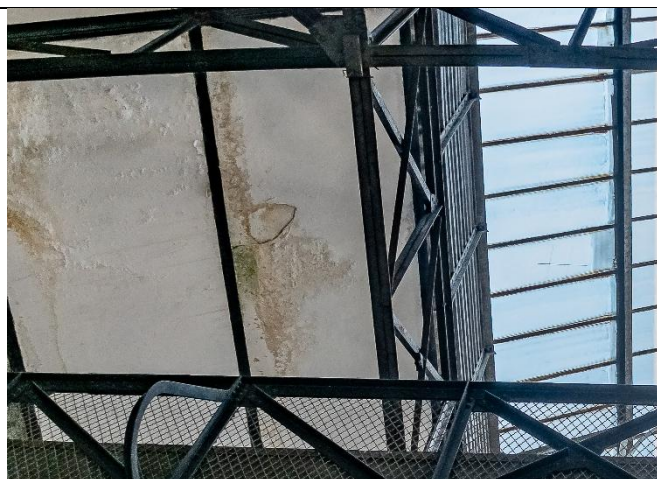
Fig.08 – Nota-se pontos de infiltração.
