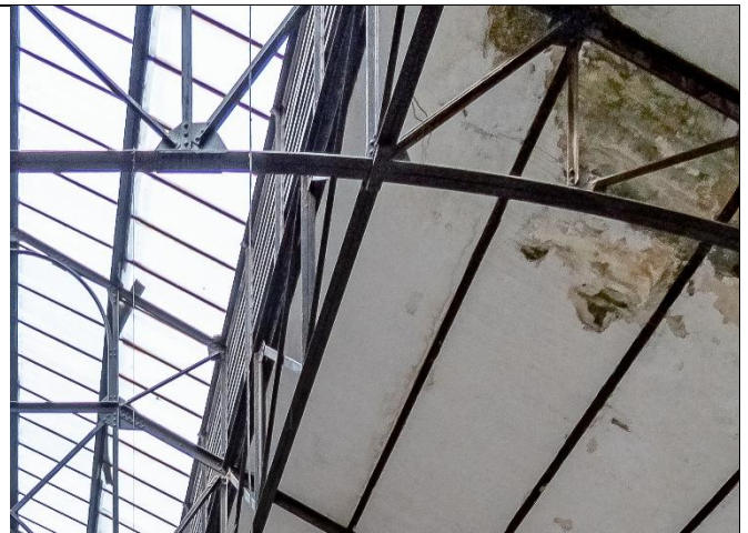
Fig.04 – Pontos de infiltração, mofo e bolor e deslocamento da pintura.
