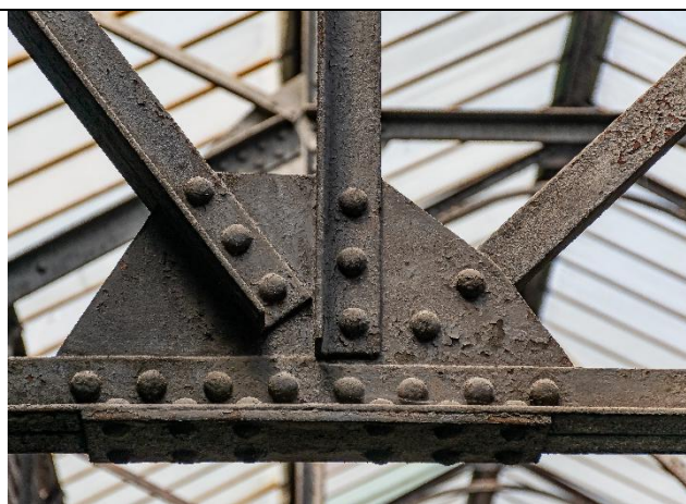
Fig.10 – Nota-se pontos de oxidação.
