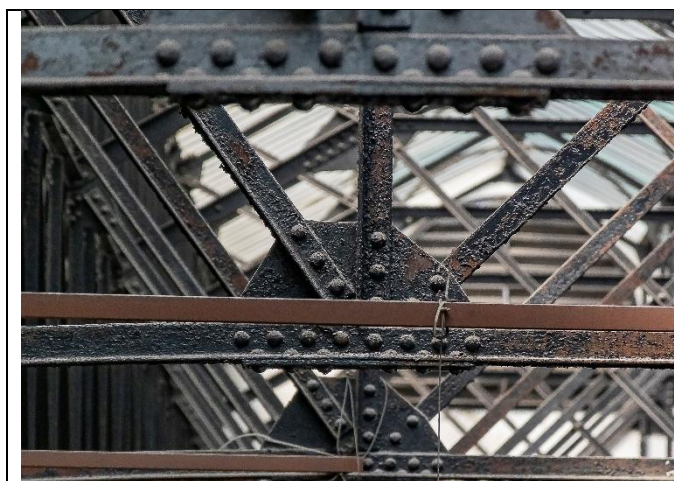
Fig.10 – Nota-se pontos de oxidação.
