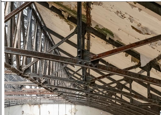
Fig.05 – Nota-se a presença de mofo e bolor e deslocamento da pintura.
