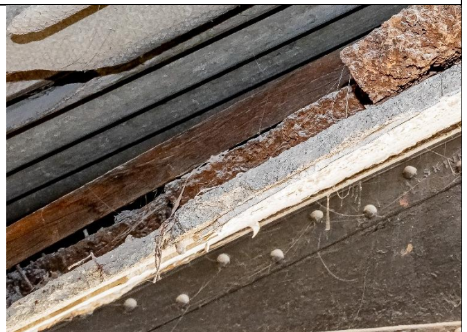
Fig.06 – Nota-se perda de seção do forro.
